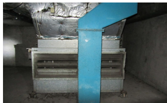
機房不堆雜物
